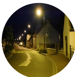
Rénovations de l'éclairage public : 12 Communes (172 609 €)
